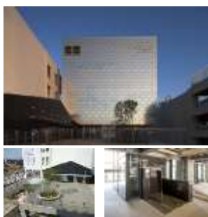
【ウェルネスプラザ】 (上段) 外観 (下段左) 多目的ホール (下段右) キッズプレイルーム 【CST】右側 3 枚 (上段) 外観 (下段左) 3 階テラス (下段右) 機械式駐輪場
