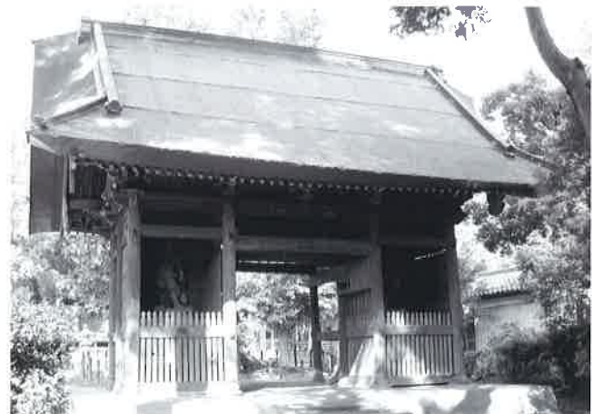
保存修理前の山門
