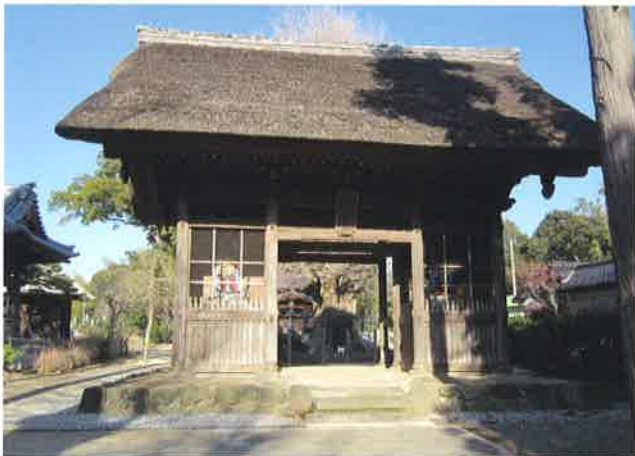
保存修理が終了した東漸寺山門(県指定文化財 元禄3年(1690))
