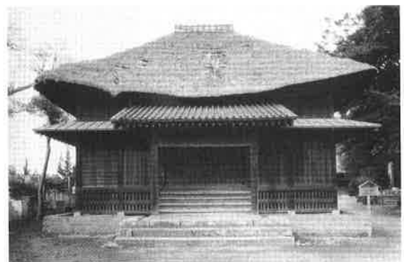
保存修理前の三仏堂
