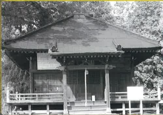
保存修理前の東漸寺観音堂
