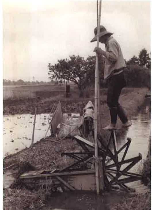
足踏み水車をまわして、用水路から田に水を引く。やや小ぶりの手でまわす水車もあり、こちらは子どもでも扱えるので、よく手伝いでまわしたそうです。動力ポンプが登場して、水車をまわさなくても水が田に引けるようになった時には、皆とても驚き喜んだそうです。
