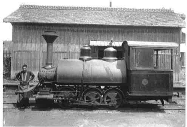
龍ヶ崎鉄道1号蒸気機関車(鉄道博物館所蔵) アメリカのボールドウィン社製で、サドルタンクの形から「亀の子」、「亀さん」と呼ばれて親しまれたそうです。
