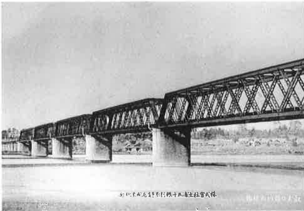
明治29年12月の開業時の日本鉄道土浦線利根川橋梁（竹内孝明氏所蔵） お雇い外国人ポーナル（イギリス人）の設計になる200フィート形（約61m） ダブルワーレントラスで、イギリスのペントシャフト・アンド・アクスルツリ 社製です。
