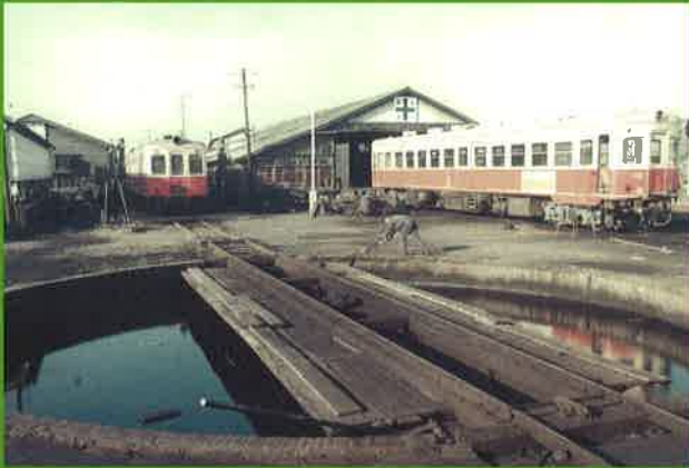
水海道機関区（関東鉄道株式会社所蔵） 手前は、蒸気機関車の向きをかえる転車台ですが、気動車の向きをかえるの にも使われました。右のキハ751形気動車は、昭和43年に譲り受けた元小田急 の車両です。
