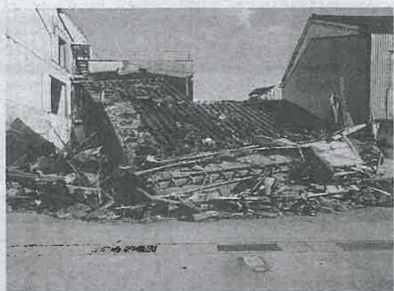
能登半島地震で倒壊した石川県七尾市内の家屋(能登・橋本庄平通信員)
